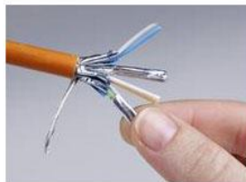
Nun lässt sich die Folie mit den Fingern abknicken und die Paarabschirmung entfernen.
