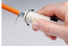
Die abgeschirmten Adernpaare in Messerpaar 2 einlegen und die Folienabschirmung anritzen.
